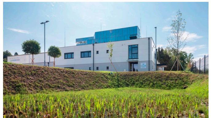
Die Algenproduktionsanlage der BDI-BioLifeScience GmbH am Ökopark in Hartberg.
